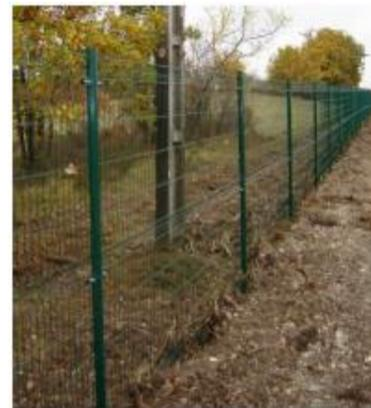
Figure 15 : Exemple de clôture souple simple torsion (Valeco)
